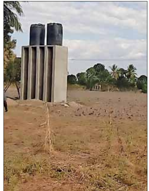
2023 begann der Bau des Bewässerungssystems
